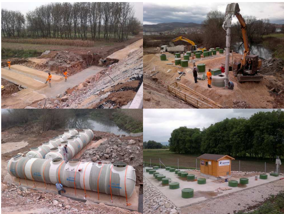
Slika 9: Ugradnja armirano-poliesterskog biološkog uređaja SBR REG 1000 na autocesti-Koridor Vc [5]
