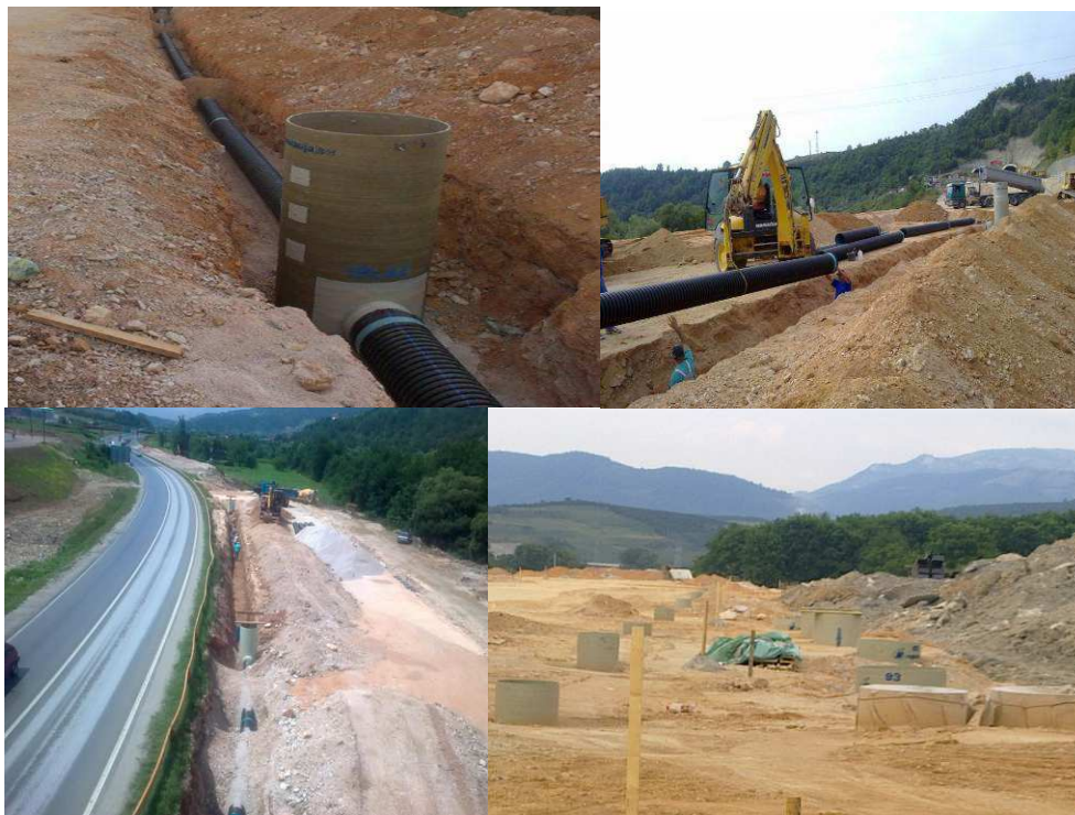
Slika 8: Ugradnja armirano-poliesterskih šahtova na autocesti - Koridor Vc [5]
