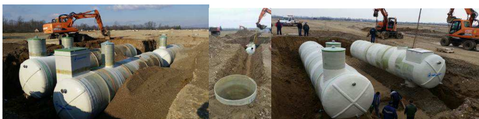
Slika 6: Primjer ugradnje uređaja od armiranog poliestera [5]
