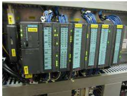
Slika 6 Programabilni logički kontroler
